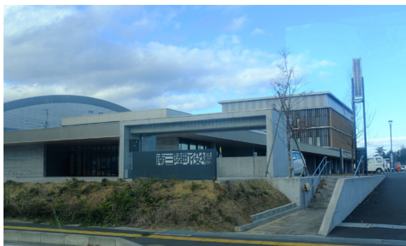
2017年8月に竣工した新庁舎の南三陸町役場
